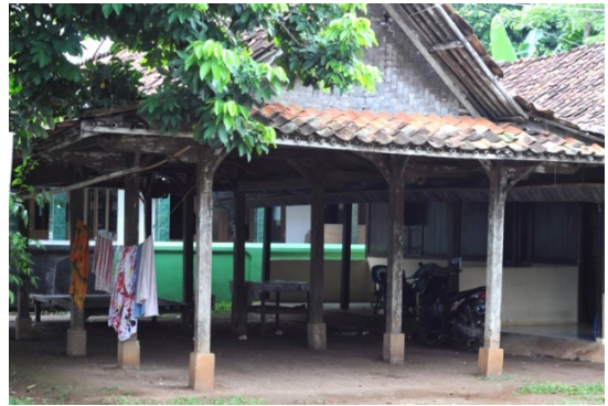
Gambar 2: Bangunan Blandongan dengan tiang-tiang dari kayu tanpa dinding (Sumber: Kompasiana.com)
